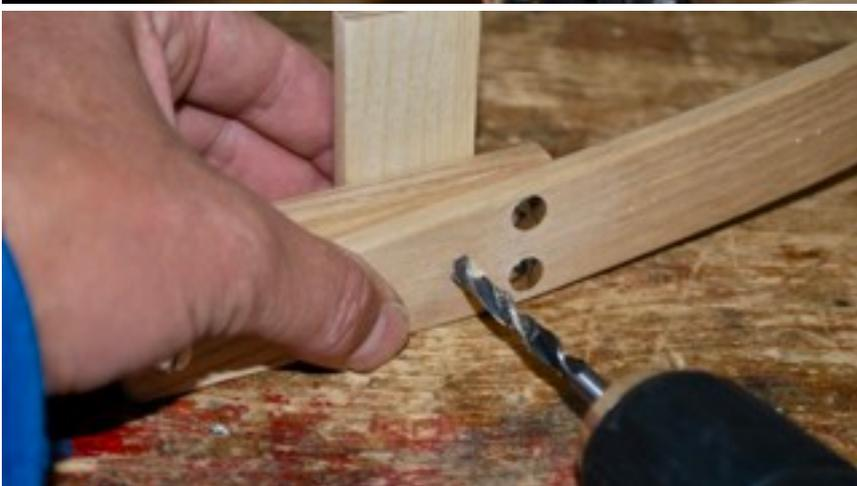
Nun die Löcher für die Seildurchführungen bohren. Ich bohre frei Hand. Eine Zulage innen verhindert ein größeres Ausreißen der Löcher innen beim Austreten des Bohrers.
